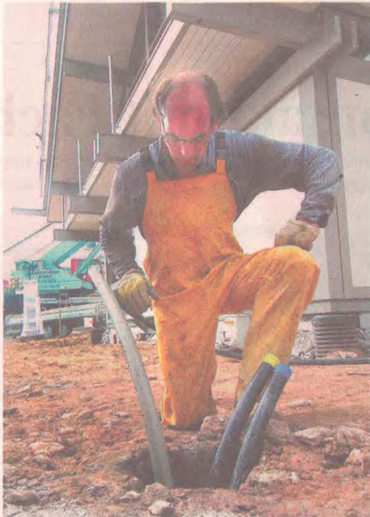
Andreas Siemetzki von der Firma R&F bohrt auf einem Grundstück an der Mozartstraße nach Erdwärme . BM-FOTO: HANS DÖRNER
